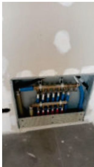
9. Collettore Radiante a Pavimento
